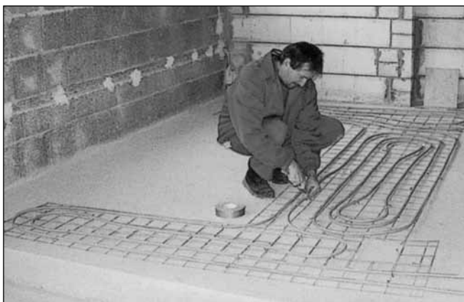
3.9. ábra. Hálózat összeszerelése a földön
