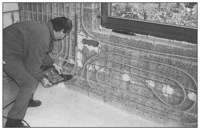
3.10. ábra. Az elkészült hálózat felerősítése a falra
