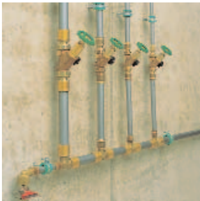
119. ábra: Hidegvíz osztó RAUTITAN stabil csövekkel
