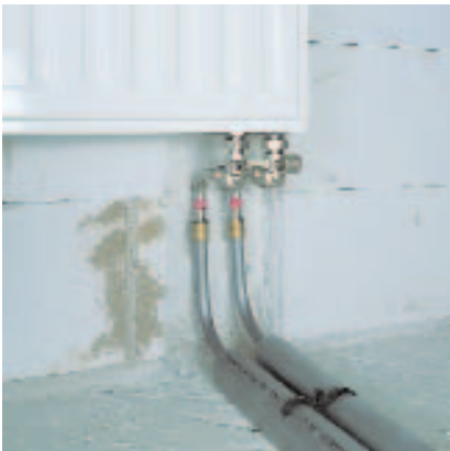
156. ábra: Csatlakozás könyökcsatlakozókkal és RAUTITAN stabil csővel
