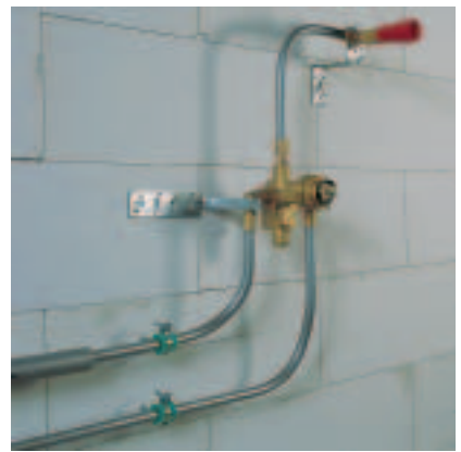
124. ábra: Vakolat alatti zuhanycsaptelep RAUTITAN stabil csövekkel
