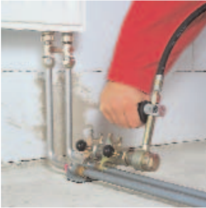
147. ábra: A toldóhüvelyes kötés létrehozása
