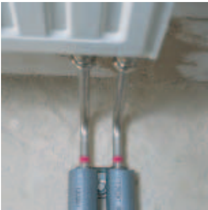
140. ábra: Bekötés padlóból kiállva könyökcsatlakozóval
