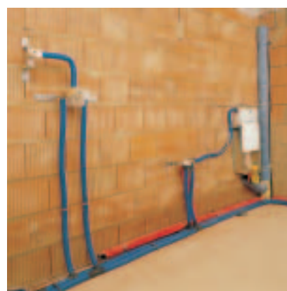
130. ábra: Szigetelt RAUHIS csövek szerelése fürdőszobában
