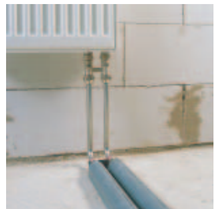
138. ábra: Az utolsó fűtőtest bekötése könyökcsatlakozóval
