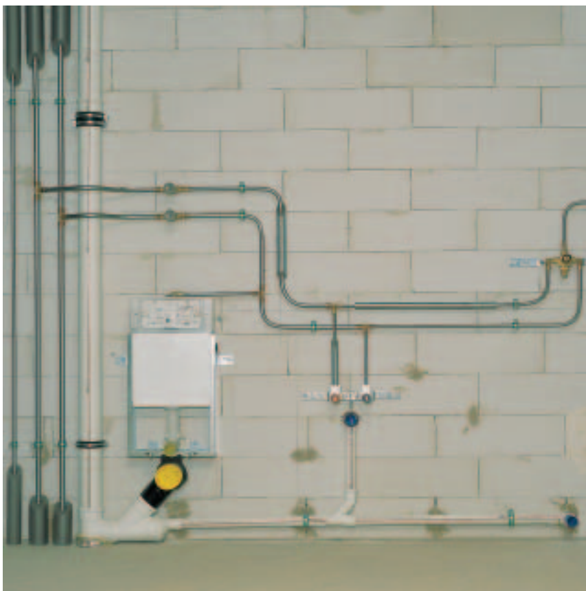
123. ábra: RAUTITAN stabil emeleti alapvezeték
