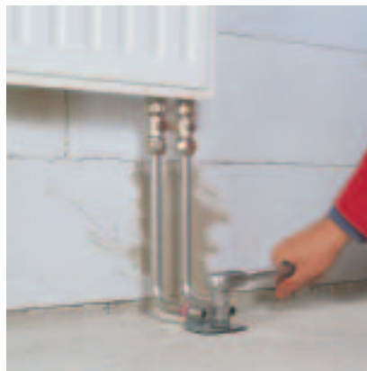
146. ábra: A rögzítő egység megfogása
