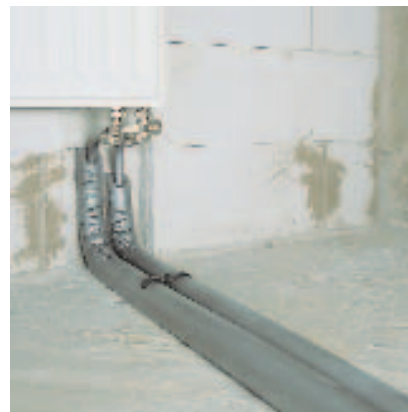
159. ábra: Közvetlen csatlakozás a golyóscsap egységhez
