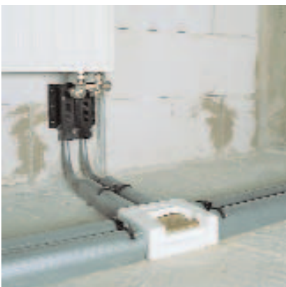
158. ábra: Csatlakozás könyökcsatlakozókkal és garnitúra rögzítő elemmel
