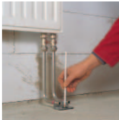
144. ábra: A rögzítő egység bejelölése
