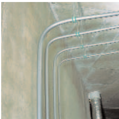
121. ábra: Felszálló vezeték meghajlított RAUTITAN stabil csövekkel
