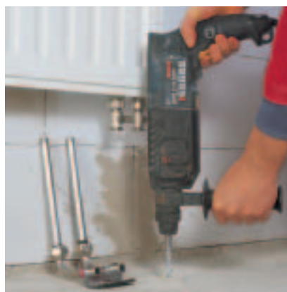
145. ábra: A rögzítő egység furatainak elkészítése
