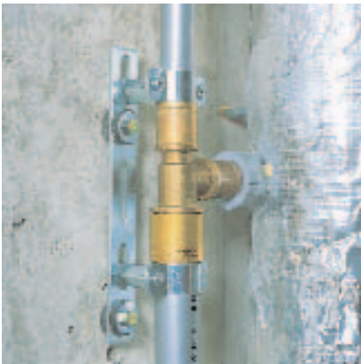
104. Fixpont fixpont-bilincsekkel
