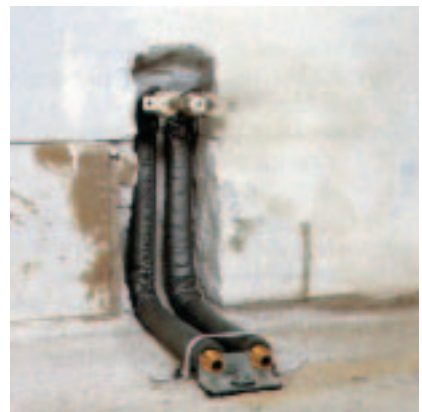
155. ábra: CuMs fali csatlakozók rövidrezáró idommal és légtelenítővel
