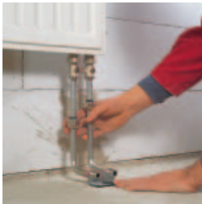
143. ábra: A csavarzat feltolása
