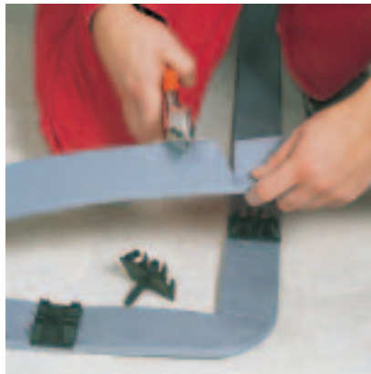
183. ábra: REHAU szigetelő csík íves fektetése
