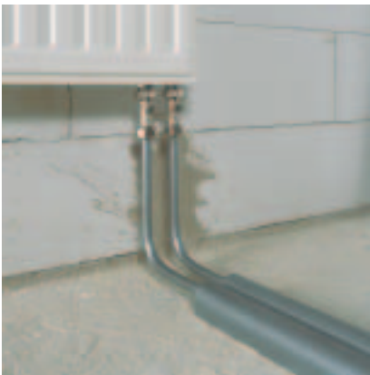
151. ábra: Közvetlen bekötés RAUTITAN stabil csővel
