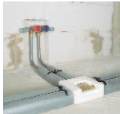
161. ábra: Szelepes kompakt fűtőtest bekötésének előkészítése
