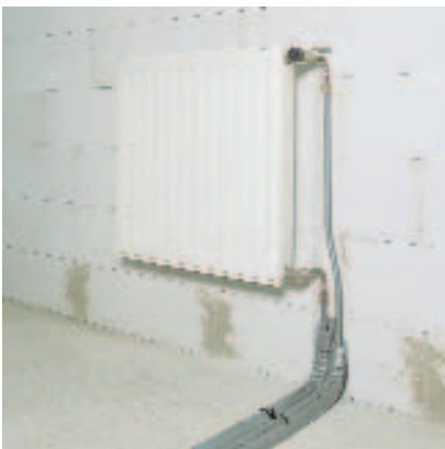
157. ábra: Fűtőtest-bekötés oldalról
