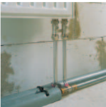
136. ábra: Fűtőtest-csatlakozás körvezeték rendszerénél
