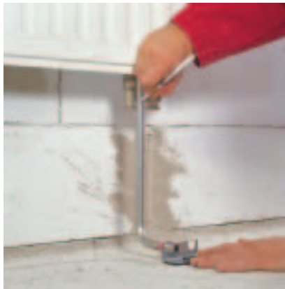
141. ábra: A könyökcsatlakozó bejelölése
