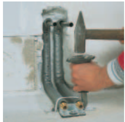
154. ábra: Biztosítás rögzítő szalaggal
