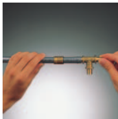
38. ábra: Az idomra ráhúzzuk a csövet. (RAUTITAN stabil esetén mind a négy tömítő borda legyen takarva)
