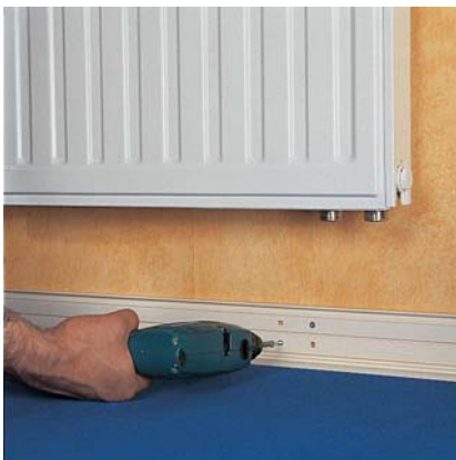
1.2.67. ábra: Az alsórész rögzítése
