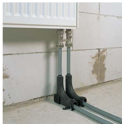
1.2.12. ábra: Fűtőtest közvetlen bekötése REHAU csővezető készlettel
