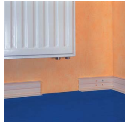
1.2.75. ábra: Felszerelt RAUSOLO csatorna alsó rész, kihagyással
