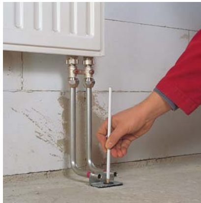
1.2.32. ábra: A rögzítő furat helyének bejelölése
