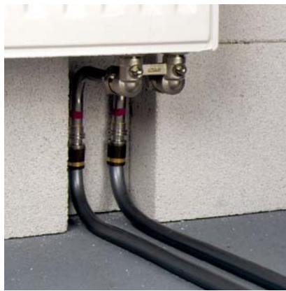
1.2.47. ábra: Beépített szelepes radiátor bekötése fal felől nemesacél könyökcsatlakozóval
