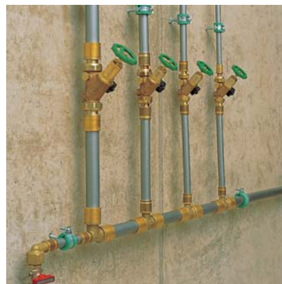
1.1.4. ábra: Hidegvíz osztó RAUTITAN stabil csövekkel
