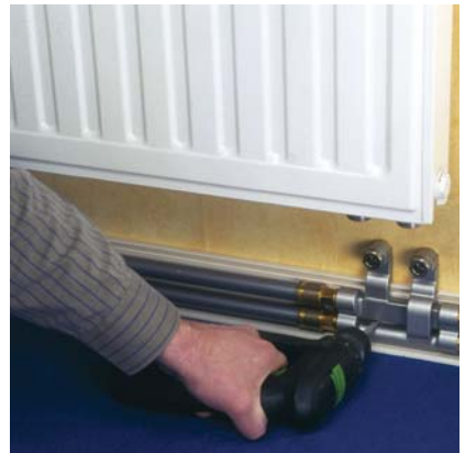
1.2.71. ábra: A REHAU SL keresztesző idom rögzítése
