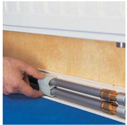
1.2.72. ábra: A REHAU csőtartó idom rögzítése
