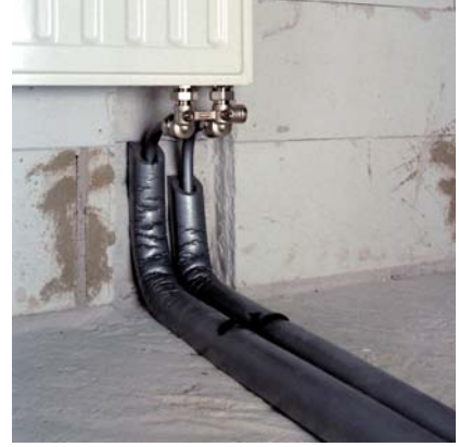
1.2.43. ábra: Közvetlen fűtőtestbekötés univerzális RAUTITAN stabil csővel
