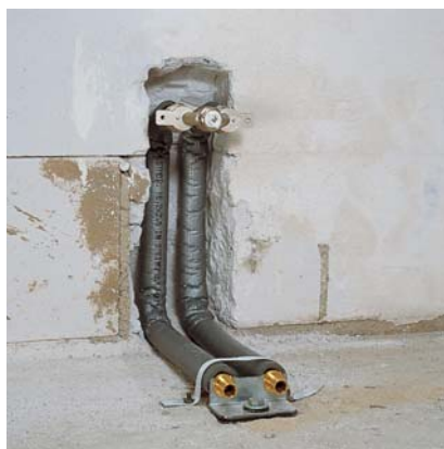
1.2.45. ábra: REHAU CuMs fal csatlakozó szett rövidre záró idommal és légtelenítővel
