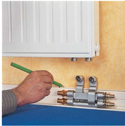
1.2.68. ábra: REHAU SL keresztesző idom, a csőhosszak bejelölése
