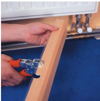
1.2.78. ábra: A csatorna felsőrész kivágása
