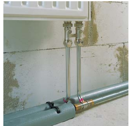
1.2.36. ábra: Beépített szelepes radiátor bekötése T-csatlakozóval
