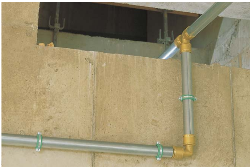
1.3.11. RAUTITAN flex csövek REHAU bepattintható csőalátámasztó héjjal szerelve
