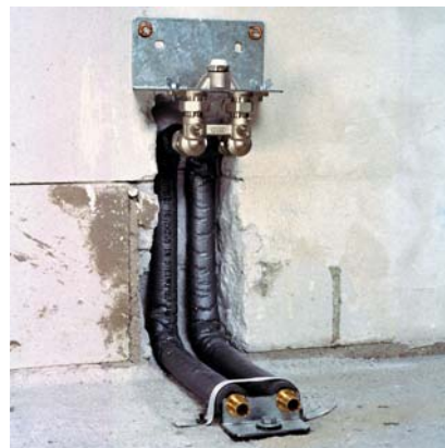
1.2.46. ábra: REHAU CuMs fal csatlakozó szett REHAU szerelősablonnal
