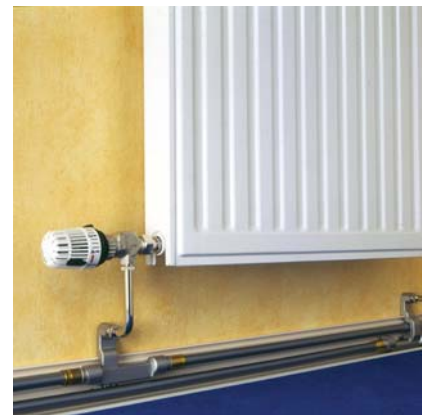
1.2.63. ábra: REHAU SL keresztvezető idom keresztkötéssel
