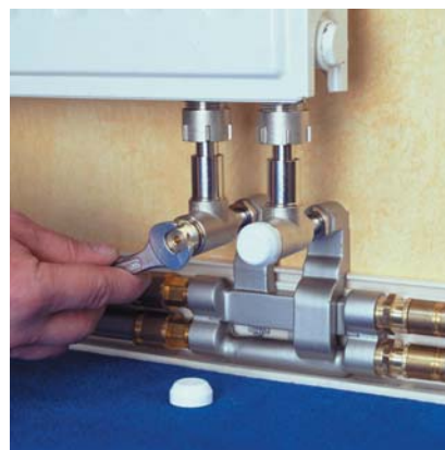
1.2.66. ábra: A szorítógyűrűs kötés kialakítása a REHAU teleszkópos könyökcsavarzat egységnél
