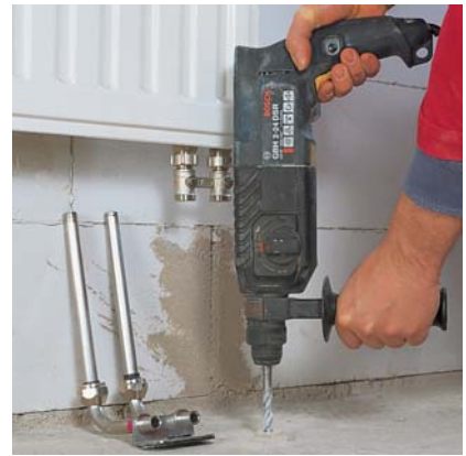
1.2.33. ábra: A rögzítőegység furatainak elkészítése
