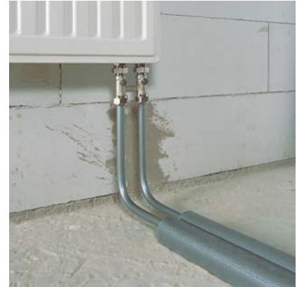
1.2.38. ábra: Közvetlen bekötés az univerzális RAUTITAN stabil csővel
