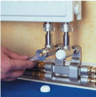
1.2.73. ábra: Szorítógyűrűs kötés létrehozása a REHAU teleszkópos könyökcsavarzat egységén
