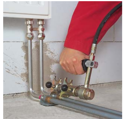
1.2.35. ábra: A toldóhüvelyes kötés létrehozása
