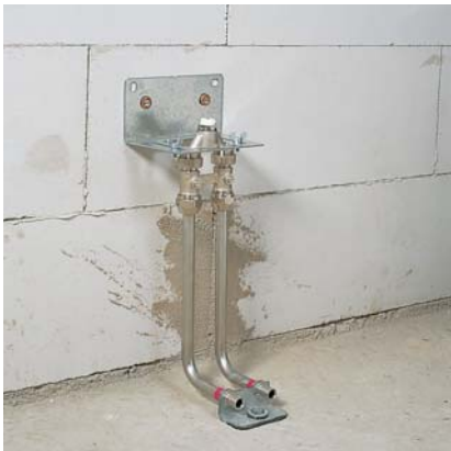
1.2.13. ábra: REHAU szerelősablon, kiállítás a padlóból
