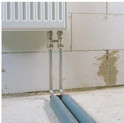
1.2.23. ábra: REHAU könyökcsatlakozó
