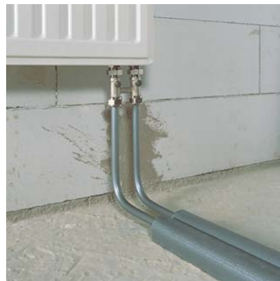
1.2.25. ábra: Közvetlen bekötés RAUTITAN stabil csővel
