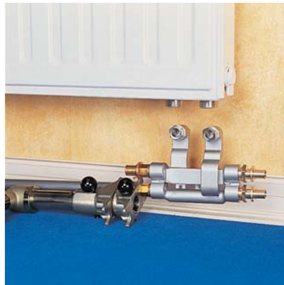
1.2.70. ábra: Toldóhüvelyes kötés elkészítése a 20 mm-es cső és a REHAU SL keresztesző idom között
