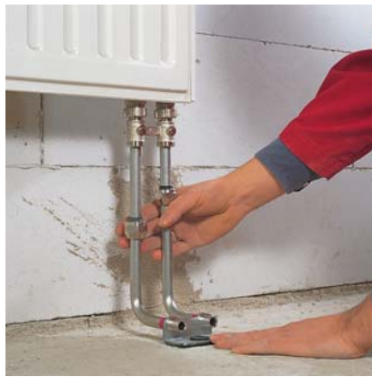
1.2.31. ábra: A könyökcsatlakozó elhelyezése
