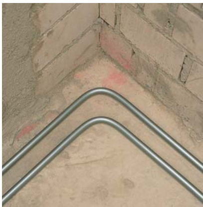
1.3.26. ábra: Meghajlított RAUTITAN stabil csövek
