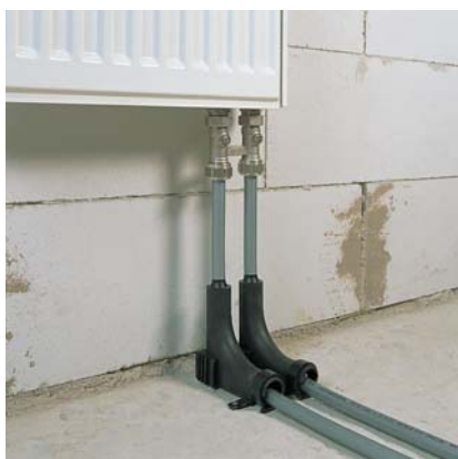
1.2.26. ábra: Közvetlen bekötés RAUTITAN flex csővel és REHAU csővezető készlettel
