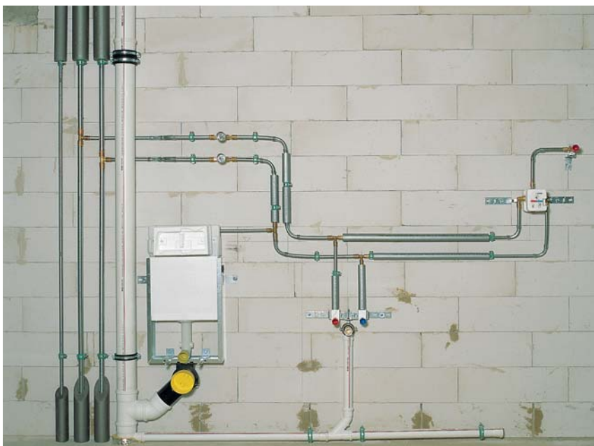
1.1.3. ábra: Példa egy fürdőszoba szerelésére RAUTITAN flex csővel
