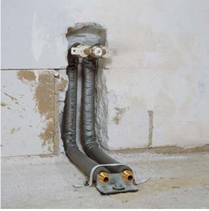
1.2.41. ábra: REHAU CuMs fal csatlakozó szett
