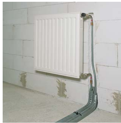
1.2.48. ábra: Fűtőtest bekötése fal felől nemesacél könyökcsatlakozóval
