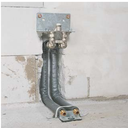
1.2.14. ábra: REHAU szerelősablon, bekötés a fal felől
