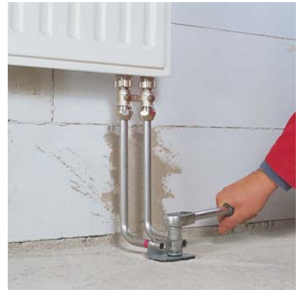
1.2.34. ábra: A rögzítőegység megfogása
