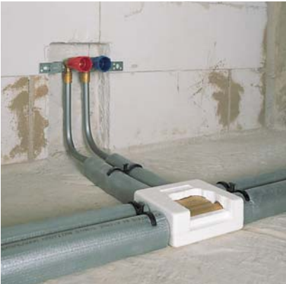
1.2.44. ábra: REHAU fűtési szerelőegység
