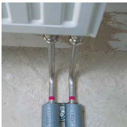
1.2.27. ábra: Bekötés padlóból a rögzítőegységet is tartalmazó REHAU könyökcsatlakozó szettel
