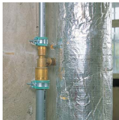
1.3.25. ábra: Példa csőbilincsel kialakított fixpontra
