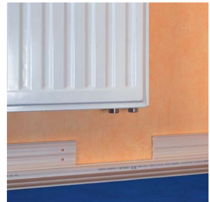
1.2.76. ábra: Felszerelt RAUDUO csatorna alsó rész, kivágással
