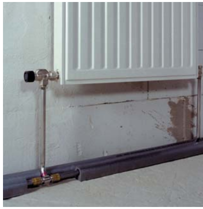
1.2.37. ábra: Közvetlen fűtőtestbekötés az univerzális RAUTITAN stabil csővel
