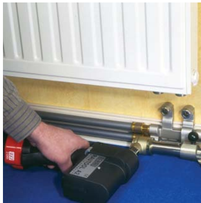
1.2.69. ábra: Toldóhüvelyes kötés elkészítése a 16 mm-es cső és a REHAU SL keresztesző idom között
